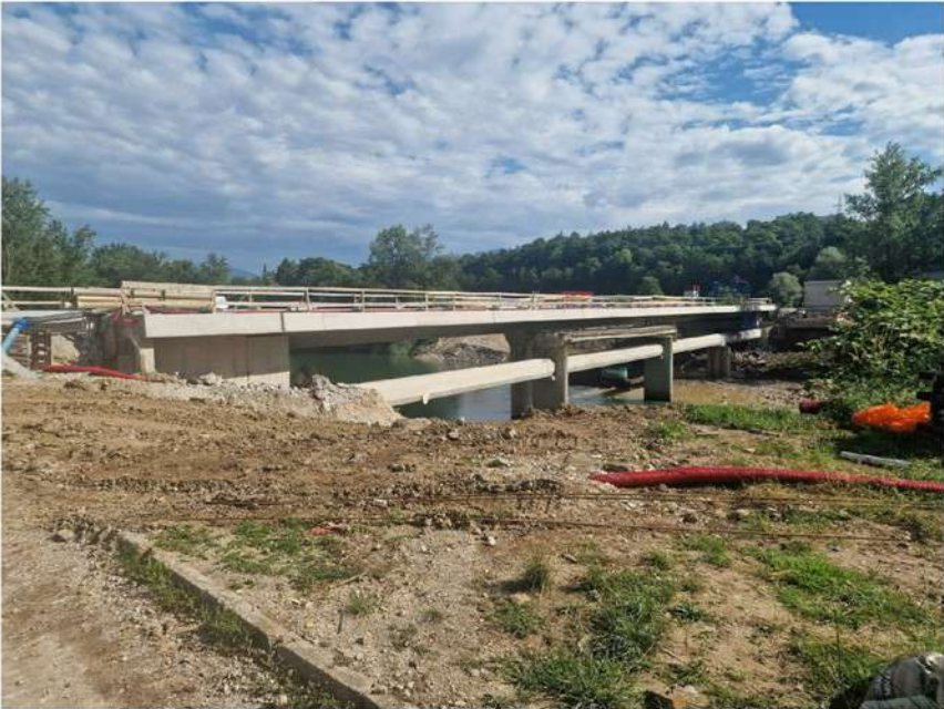
Foto: Mestna občina Kranj
